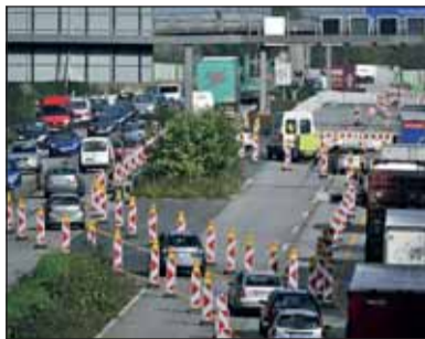
Baustelle mit Spurwechsel: Die linke Spur ist nur für PWs.
