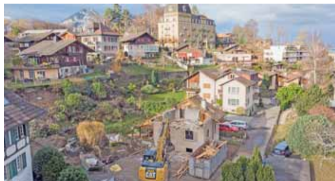
Die Abbrucharbeiten haben begonnen. Ab Februar 2022 soll das neue 5-Familienhaus bezugsbereit sein. Die Wohnungen sind auch als Zweitwohnungen nutzbar.
